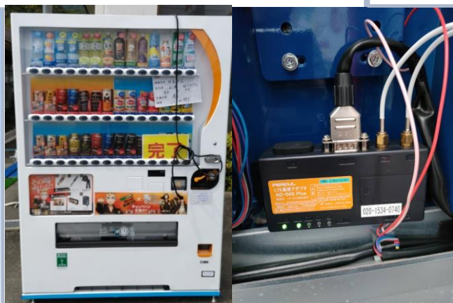
自販機に設置 した通信機 (126台)
